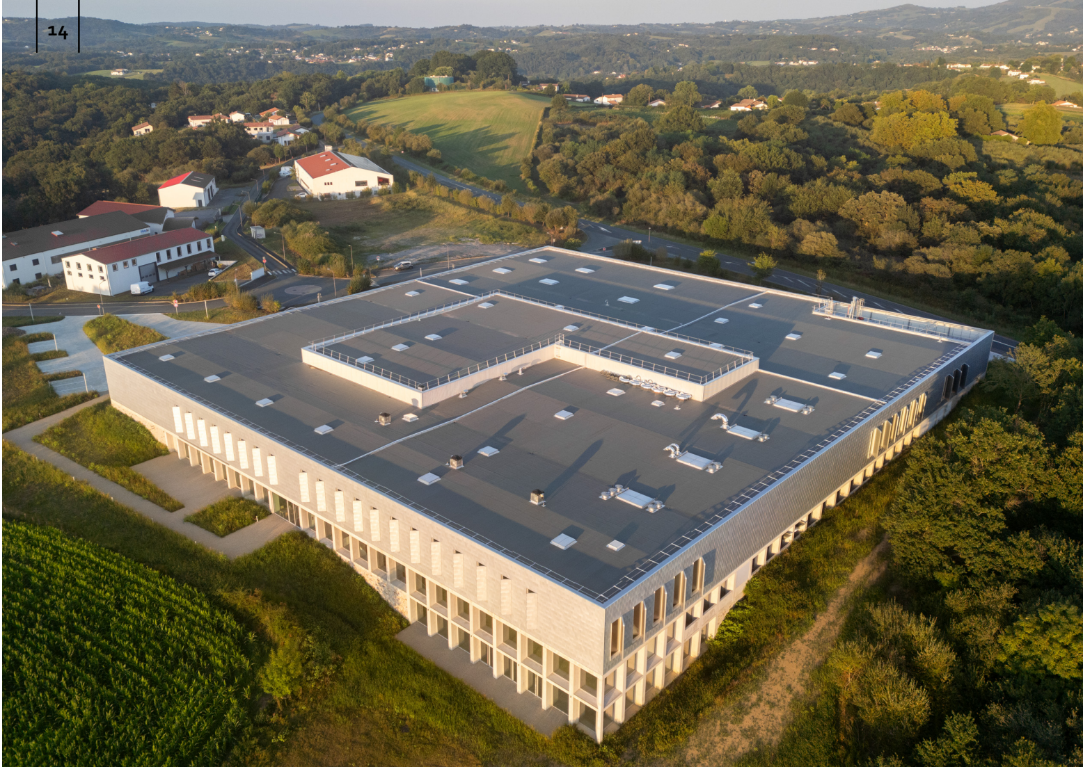
Un bâtiment industriel novateur dédié à la production des sièges Alki, fleuron français du mobilier design.
